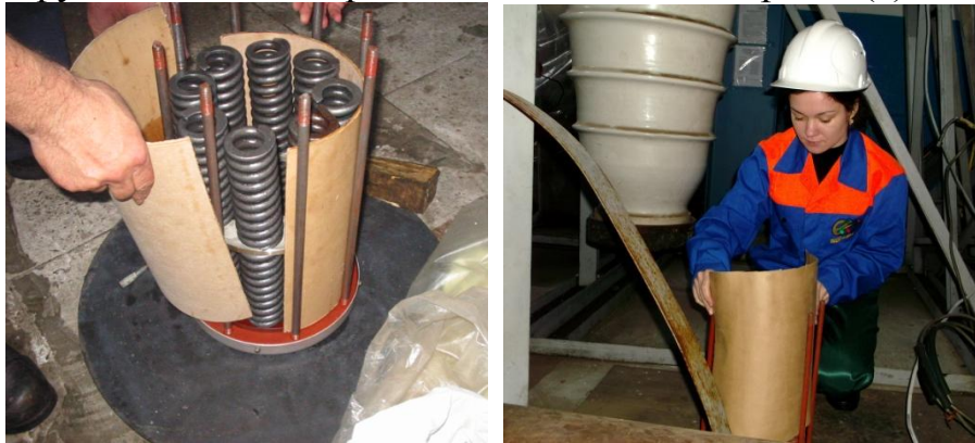
Рис. 6. Ізоляція пружин від корпусу головки вводу
