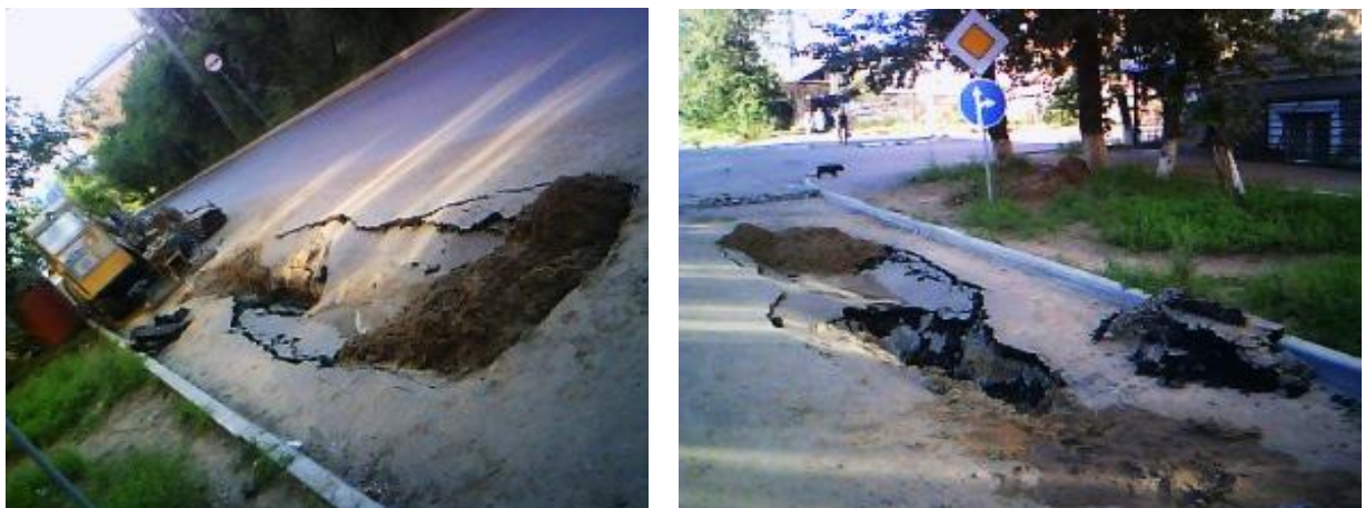
Рис. 2. Деформації поверхні при проведенні ГНБ в міських умовах
