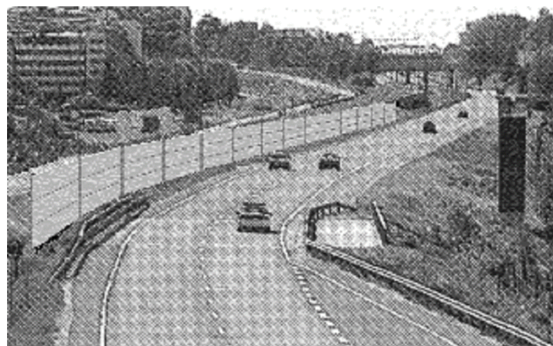
Рис. 4. Шумозахисні придорожні екрани з композиційних матеріалів, розроблені ЦНДІБМ
