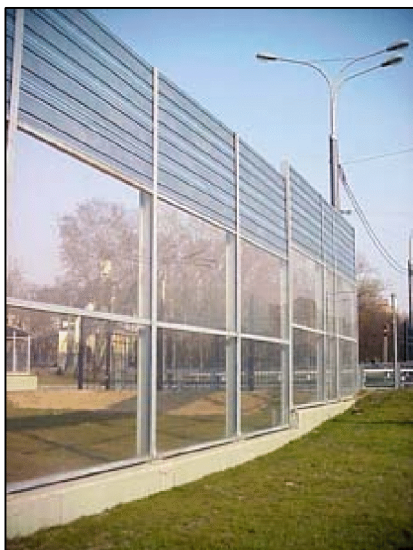
Рис. 5. Шумозахисні екрани, встановлені на Московській автомобільній кільцевій дорозі
